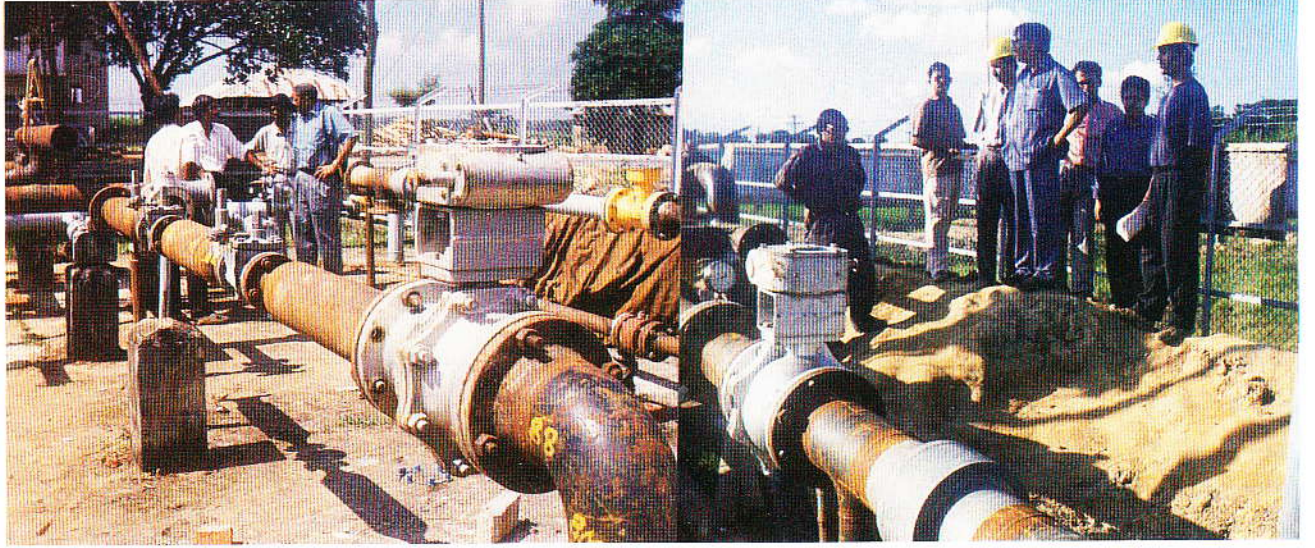
ডিআরএস আপগ্রেশন কাজ পরিদর্শনে কোম্পানীর ব্যবস্থাপনা পরিচালক (ডানে) ও এস গ্র্যান্ড ই, আই প্রকল্পের পরামর্শক (বামে)
